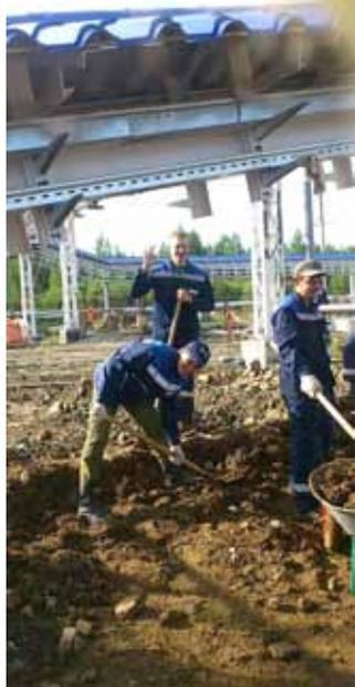
рован кабель связи КИП. Для этого была выкопана траншея длиной 40 метров, глубиной 1,7 метра, шириной 1 метр; среди высоковольтных и опτικο-волоконных кабелей найден нужный, обкопаны гильзы у дороги, заменен весь провод, подсыпана «подушка» из отсева толщиной 150 мм, уложена сигнальная лента, и всё это было вновь закопано.
